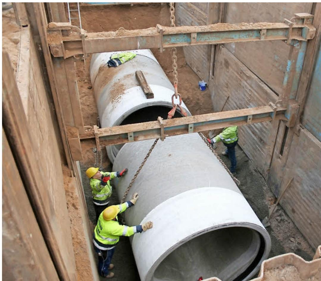
Noch vor wenigen Wochen an der Kanalbaustelle in der Hallstadter Straße: In tiefen Gruben werden die Rohre für den neuen Mischwasserkanal versenkt. Mittlerweile sind die Baugruben geschlossen. Am morgigen Dienstag ist die Straße wieder frei.
